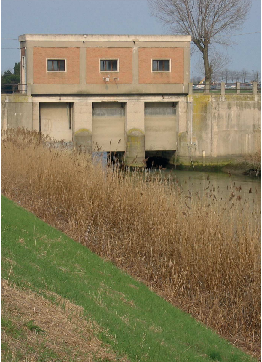
Figura 2. Il manufatto Chiavica sul Canale Montalbano a valle della botte.
