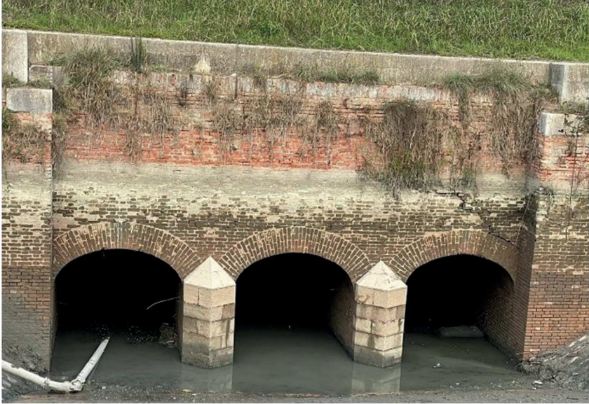
Prospetto di monte Prima dei lavori
