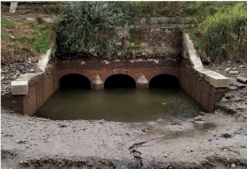
Prospetto di valle Prima dei lavori
