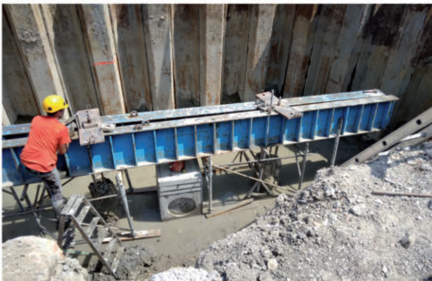
Fig. 32 - Prova di carico del palo campione
