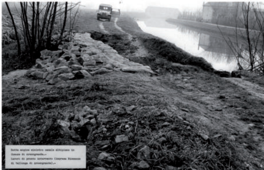
Fig. 10 - Alluvione 1966: rotta argine sinistro canale Altipiano in Comune di Arzergrande
