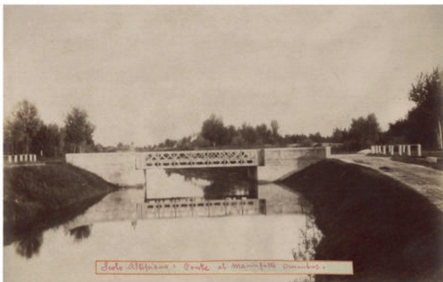
Fig. 6 - Scolo Altipiano - Ponte al manufatto Omnibus
