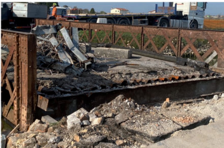
Fig. 24 - Demolizioni preliminari delle vecchie strutture in muratura
