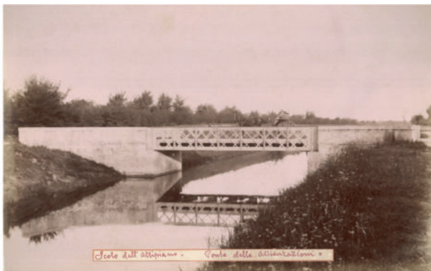
Fig. 5 - Scolo Altipiano - Ponte delle Assicurazioni
