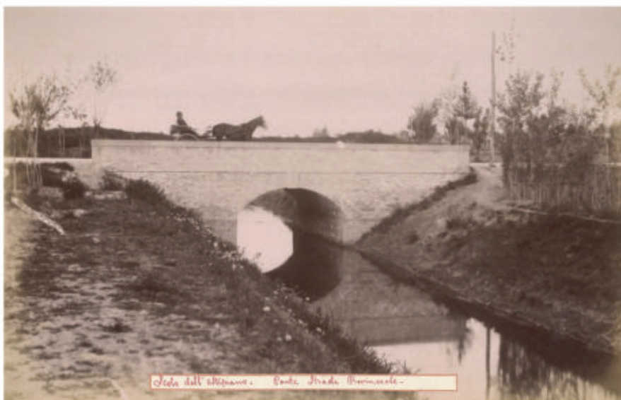
Fig. 9 - Scolo Altipiano - Ponte Strada Provinciale
