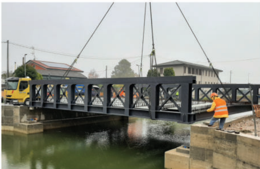
Fig. 39 - Fase finale di varo della struttura nella sede definitiva
