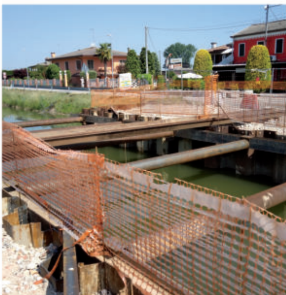
Fig. 27 e 28 - Infissione di diaframmi provvisori in palancole di acciaio fino in sommità arginale, rinforzate e puntellate e loro riempimento con terreno
