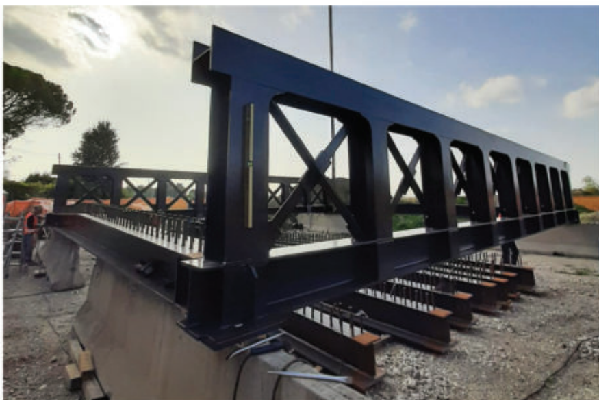
Fig. 37 - Assemblaggio del nuovo impalcato in cantiere
