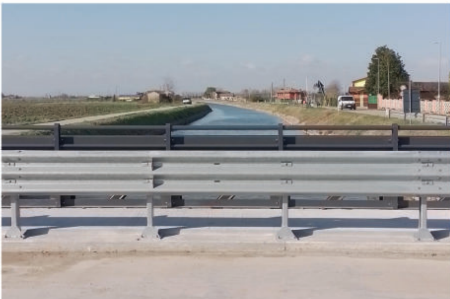
Fig. 44 - Posizionamento parapetti e guard-rail
