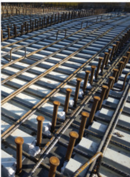
Fig. 40 - Armatura impalcato
