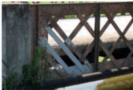
Fig. 22 - Ripristino di asta diagonale
