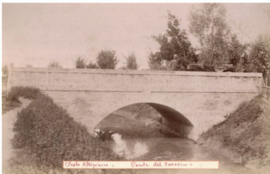
Fig. 7 - Scolo Altipiano - Ponte del Caserin
