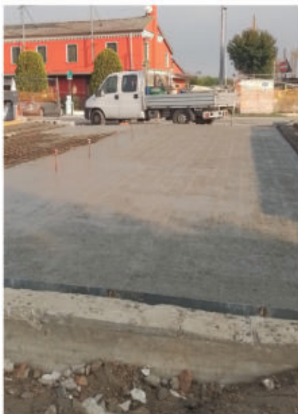
Fig. 41 - Getto in opera della soletta in calcestruzzo armato
