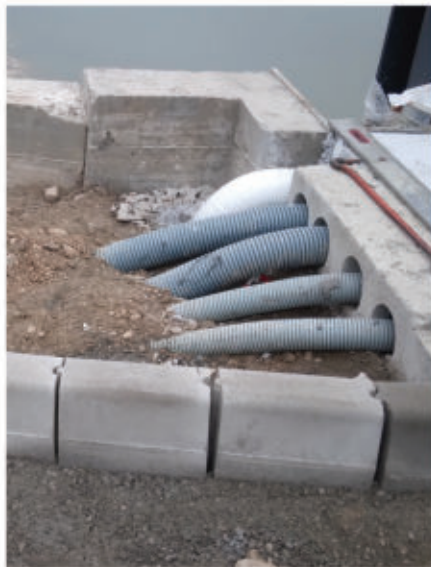
Fig. 43 - Ripristino delle condotte di acqua, gas e linee telefoniche
