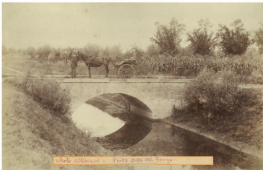
Fig. 3 - Scolo Altipiano - Ponte detto del Fango
