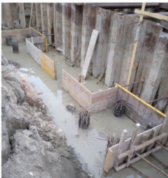
Fig. 33 e 34 - Armatura, casseratura e getto in opera delle spalle di appoggio del nuovo ponte e dei muri d'ala laterali
