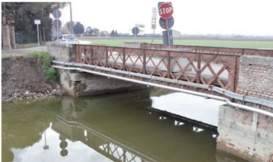
Fig. 16 - Vista del vecchio ponte da via Altipiano
