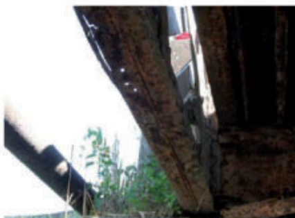
Fig. 20 - Rotture longitudinali e fori per mancanza di chiodi
