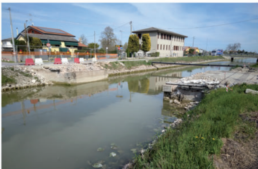
Fig. 26 - Vista successiva alla rimozione dell'impalcato
