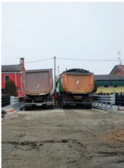
Fig. 47 - Collaudo statico del ponte
