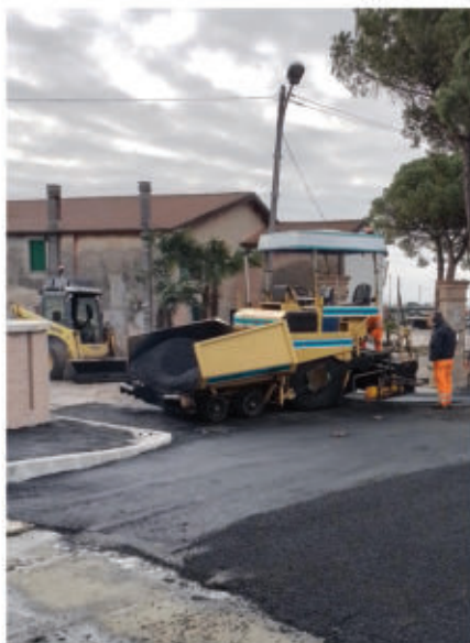
Fig. 48 - Asfaltatura della strada
