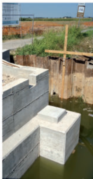
Fig. 33 e 34 - Armatura, casseratura e getto in opera delle spalle di appoggio del nuovo ponte e dei muri d'ala laterali
