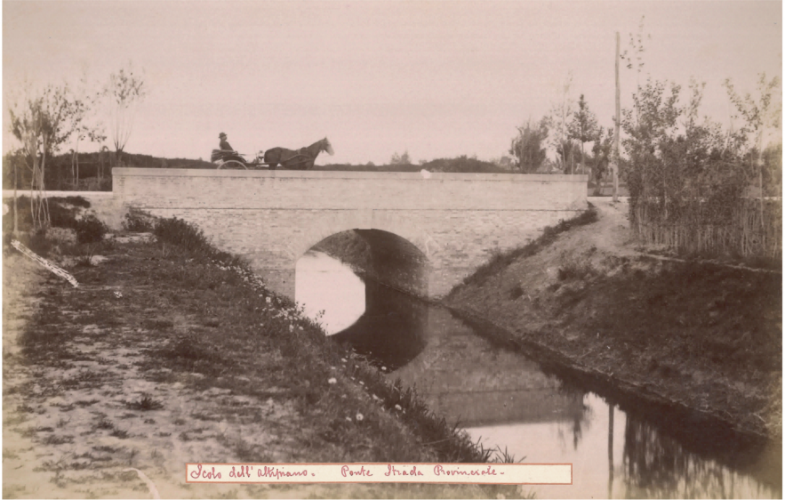
Fig. 9 - Scolo Altipiano - Ponte Strada Provinciale
