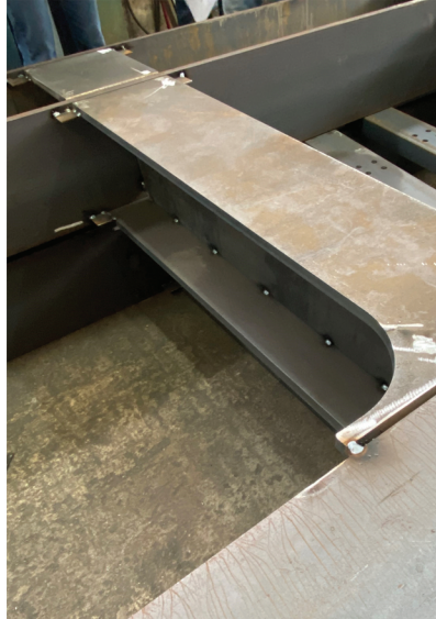
Fig. 35 e 36 - Preparazione in officina delle strutture del nuovo impalcato: 2 travi reticolari laterali e 9 travi trasversali rastremate
