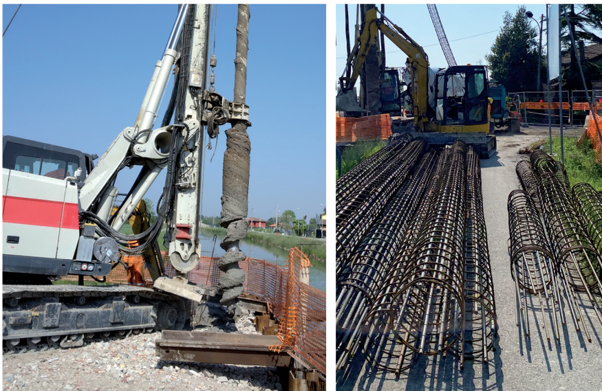
Fig. 29 e 30 - Trivellazione e getto in opera di 17 pali di fondazione FDP (Full Displacement Piles) di cui 1 palo ausiliario di servizio alla prova di carico
