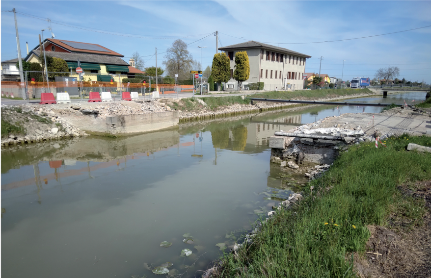
Fig. 26 - Vista successiva alla rimozione dell'impalcato
