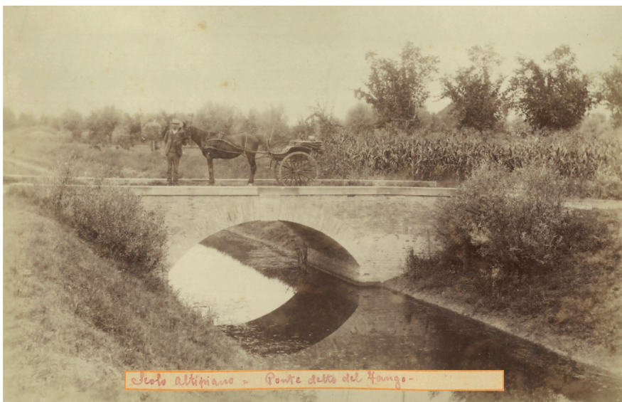
Fig. 3 - Scolo Altipiano - Ponte detto del Fango
