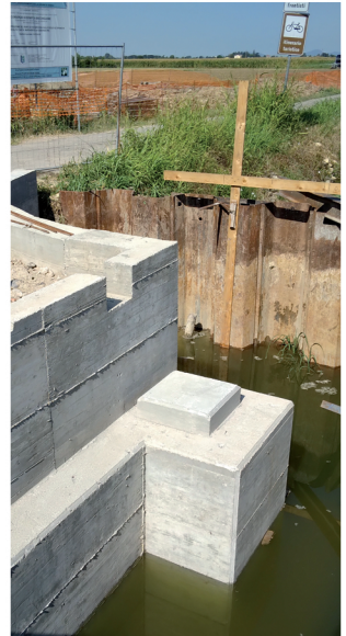
Fig. 33 e 34 - Armatura, casseratura e getto in opera delle spalle di appoggio del nuovo ponte e dei muri d'ala laterali
