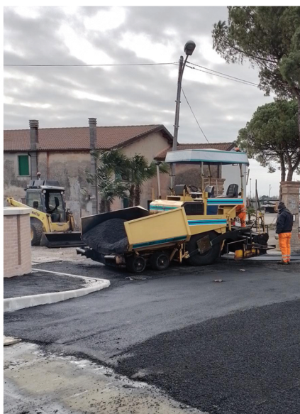
Fig. 48 - Asfaltatura della strada
