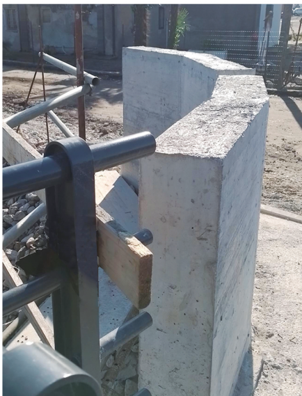
Fig. 45 - Getto in opera dei muri laterali in calcestruzzo armato
