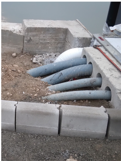
Fig. 43 - Ripristino delle condotte di acqua, gas e linee telefoniche
