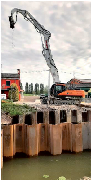
Fig. 27 e 28 - Infissione di diaframmi provvisori in palancole di acciaio fino in sommità arginale, rinforzate e puntellate e loro riempimento con terreno
