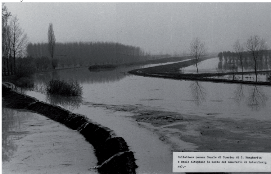
Fig. 11 - Alluvione 1966: collettore comune Canale di Scarico di S. Margherita e scolo Altipiano
