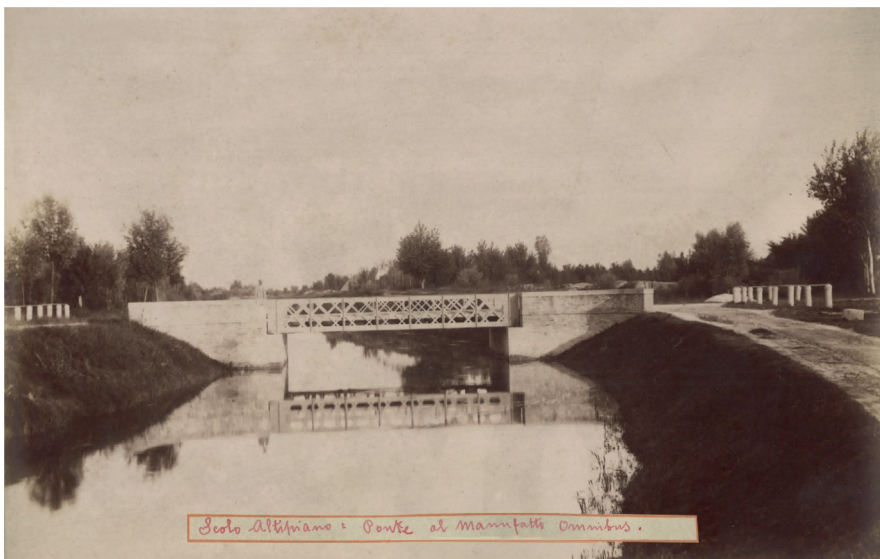
Fig. 6 - Scolo Altipiano - Ponte al manufatto Omnibus
