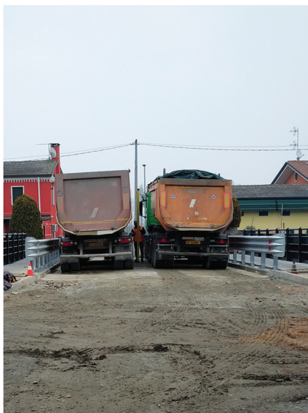
Fig. 47 - Collaudo statico del ponte
