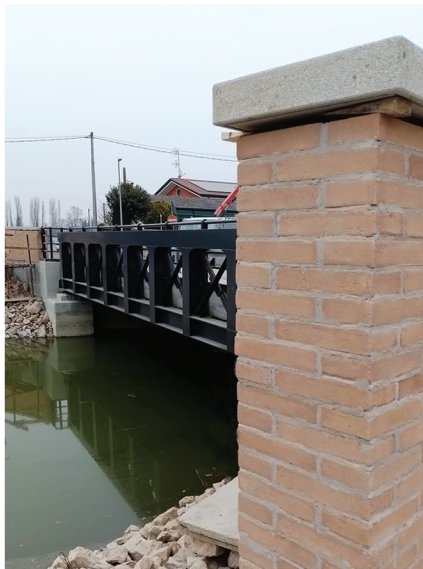
Fig. 46 - Rivestimento dei muri laterali in pietre e blocchi di trachite
