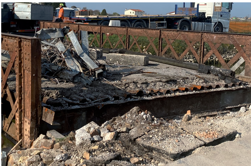
Fig. 24 - Demolizioni preliminari delle vecchie strutture in muratura Fig. 25 - Rimozione del vecchio impalcato (pagina seguente)
