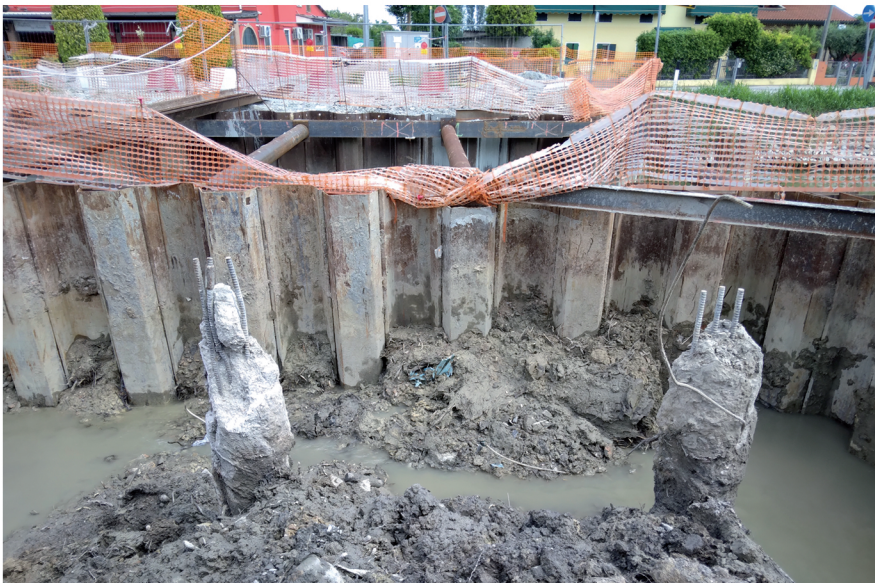
Fig. 31 - Scavi all'interno dei diaframmi e scapitozzamento dei pali fino alle quote di progetto
