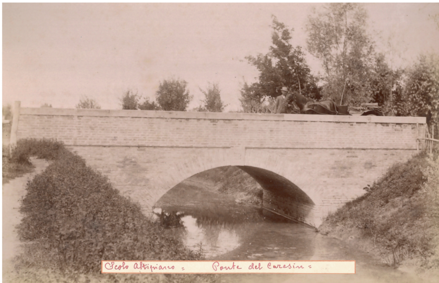
Fig. 7 - Scolo Altipiano - Ponte del Caserin
