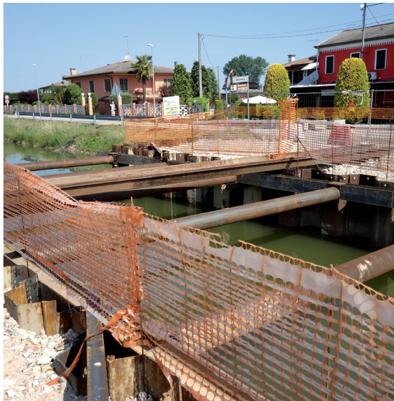
Fig. 27 e 28 - Infissione di diaframmi provvisori in palancole di acciaio fino in sommità arginale, rinforzate e puntellate e loro riempimento con terreno
