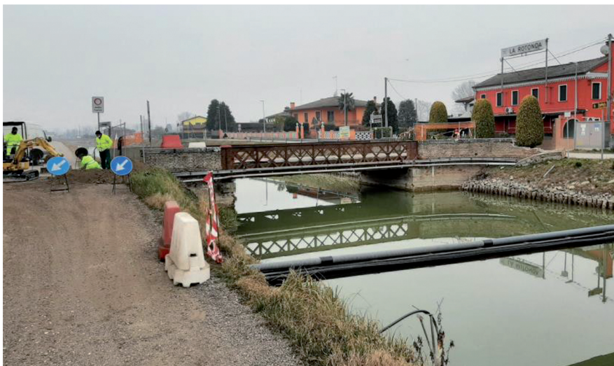
Fig. 23 - Spostamento e by-pass provvisori delle condotte di acqua, gas e linee telefoniche
