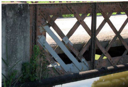
Fig. 22 - Ripristino di asta diagonale
