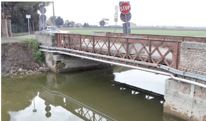
Fig. 16 - Vista del vecchio ponte da via Altipiano
