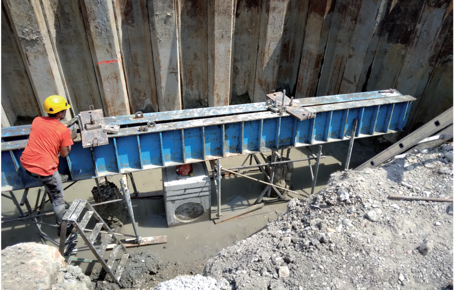
Fig. 32 - Prova di carico del palo campione
