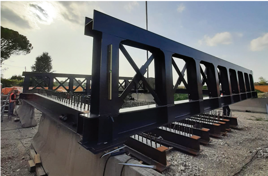
Fig. 37 - Assemblaggio del nuovo impalcato in cantiere
