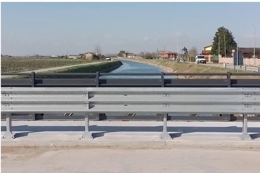
Fig. 44 - Posizionamento parapetti e guard-rail
