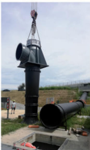
Fig. 15 - Installazione di una delle due nuove elettropompe
