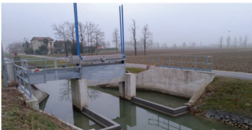
Fig. 28 - Sostegno a Brugine sul canale Altipiano
