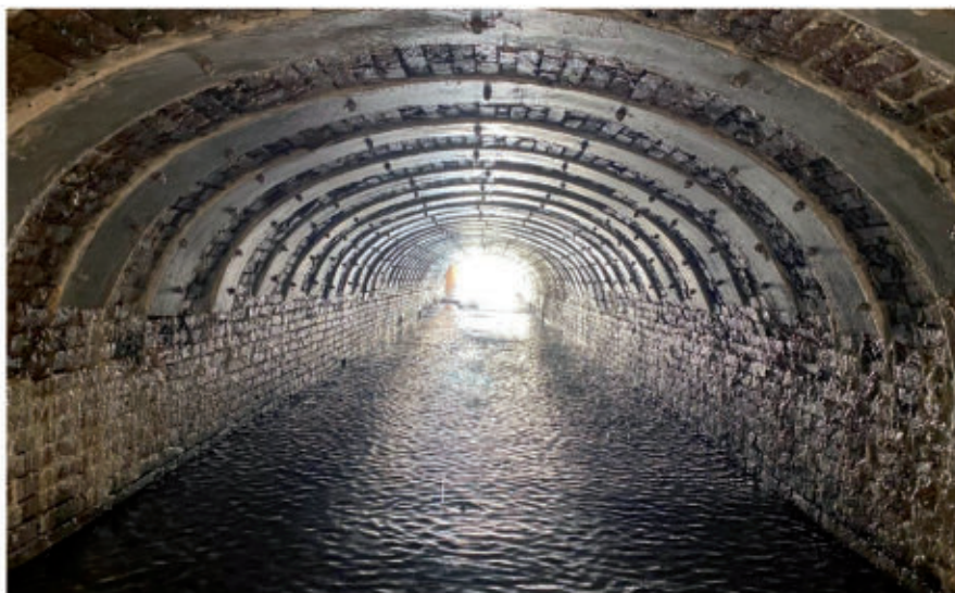
Fig. 24 - Canna 1 di monte: messa in sicurezza e ripristino della volta
