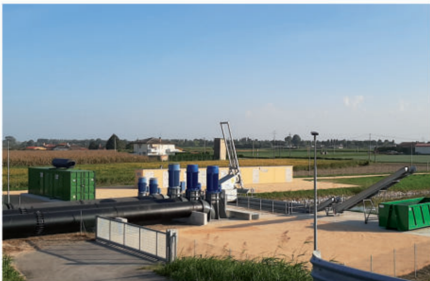
Fig. 18 - Sistemazione finale dell'area del nuovo impianto
