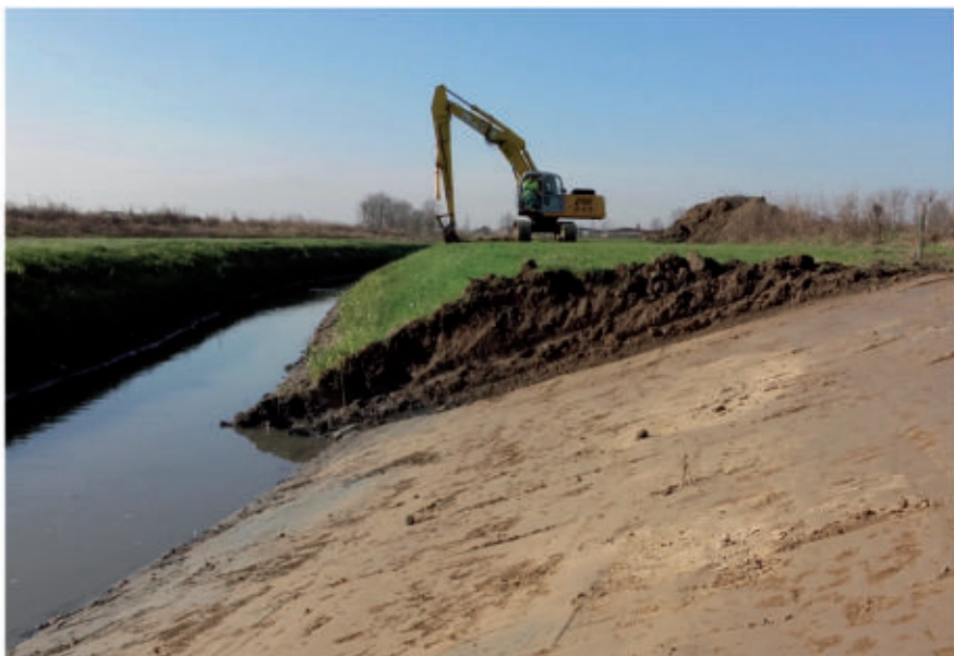
Fig. 35 - Allargamento della sezione del canale Altipiano con pendenza delle sponde molto ridotta
