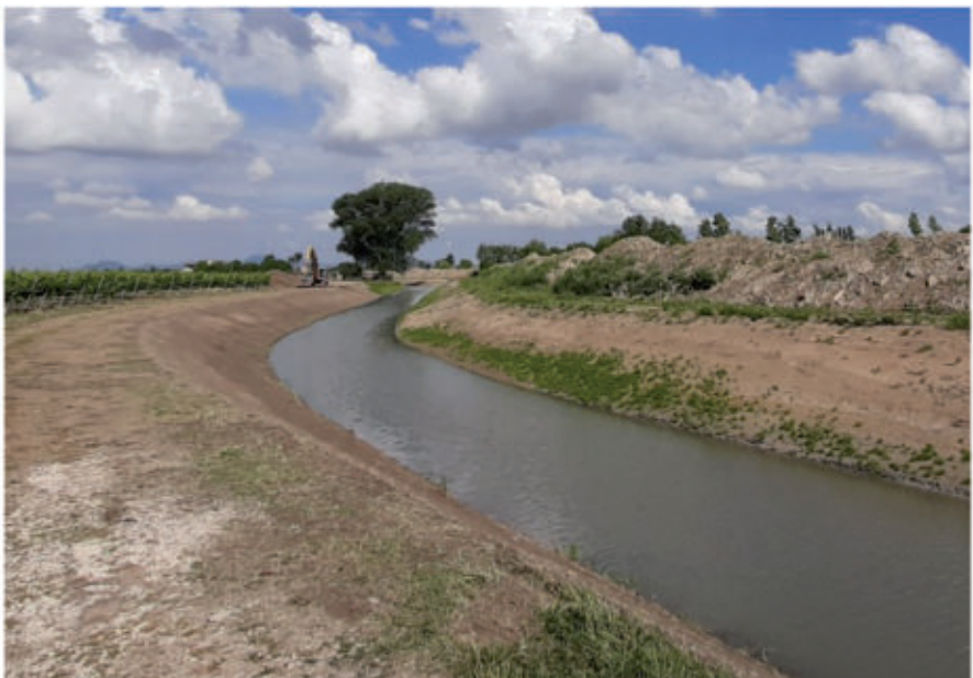
Fig. 30 e Fig. 31: Lavori di ricalibratura del canale Altipiano
