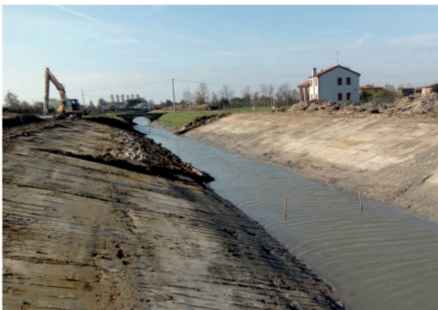
Fig. 32 e Fig. 33 - Lavori di ricalibratura del canale Altipiano
