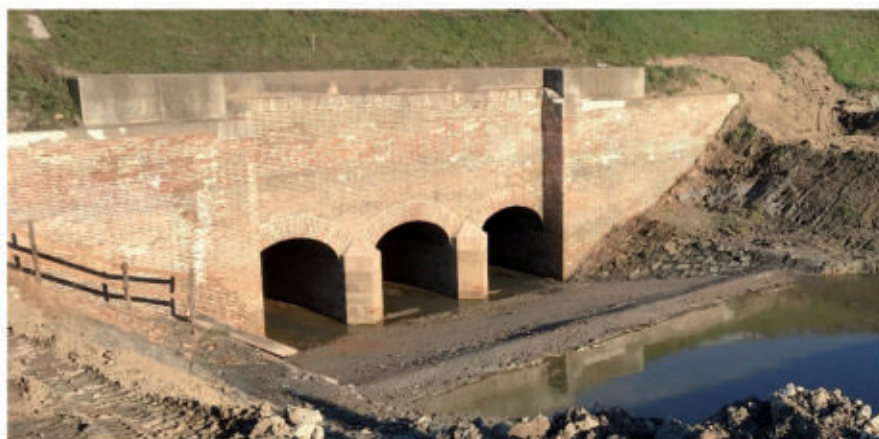
Fig. 22 - Prospetto di monte della botte di Conche dopo i lavori
