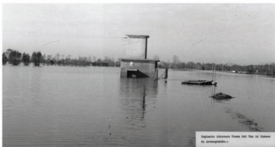
Fig. 9 - Alluvione 1966: l'impianto idrovoro "Fossa del Pan" in comune di Arzergrande
