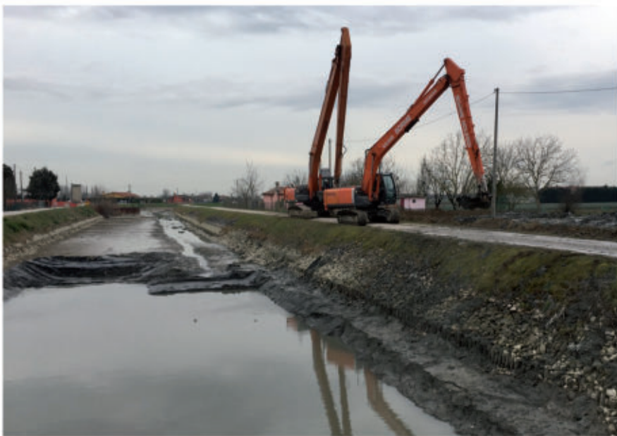
Fig. 34 - Lavori di espurgo del tratto arginato del canale Altipiano
