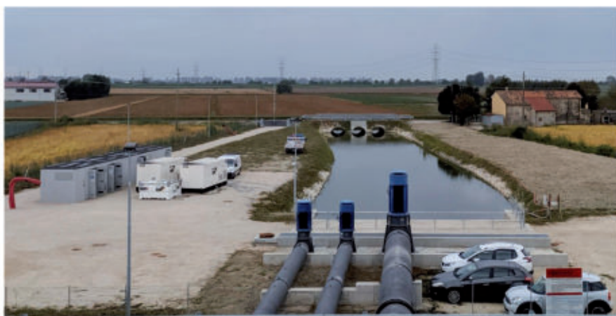
Fig. 12 - Foto dall'argine destro del Fiume Brenta al termine dei lavori
