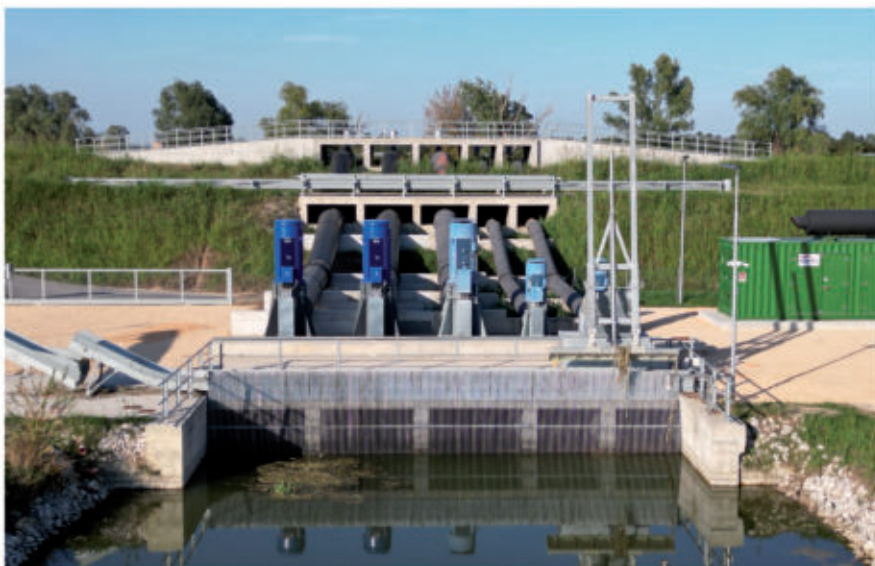
Fig. 17 - Nuovo sistema automatico di sgrigliatura a lavori ultimati
