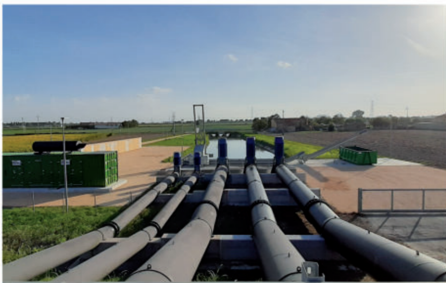
Fig. 19 - Foto dall'argine destro del Fiume Brenta Fig. 20 e Fig. 21 - Viste aeree del nuovo impianto ( pagine seguenti )
