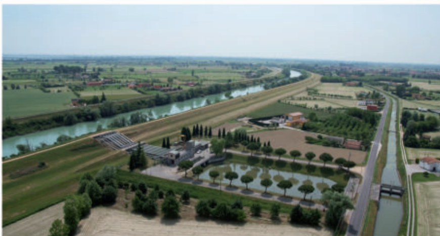
Fig. 7 - L'impianto idrovoro di Cambroso
