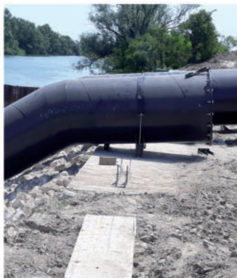
Fig. 13 - Vista laterale di uno dei due tratti terminali delle tubazioni di scarico
