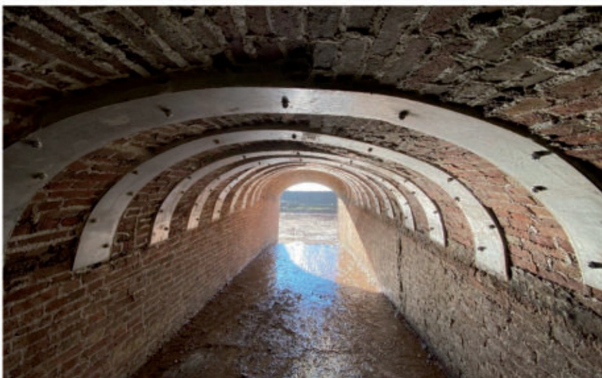
Fig. 26 - Canna 2 centrale: messa in sicurezza e ripristino della volta
