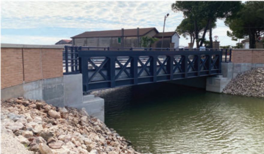
Fig. 38 - Il nuovo ponte sul canale Altipiano a Santa Margherita di Codevigo
