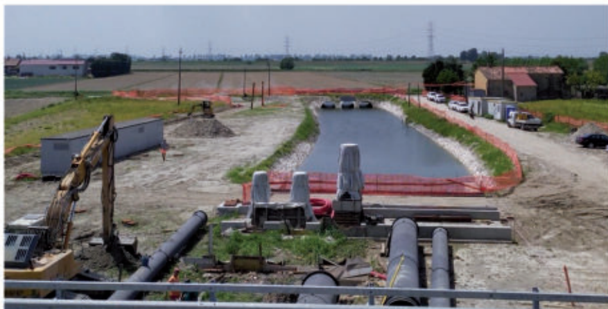
Fig. 11 - Foto dall'argine destro del Fiume Brenta durante i lavori
