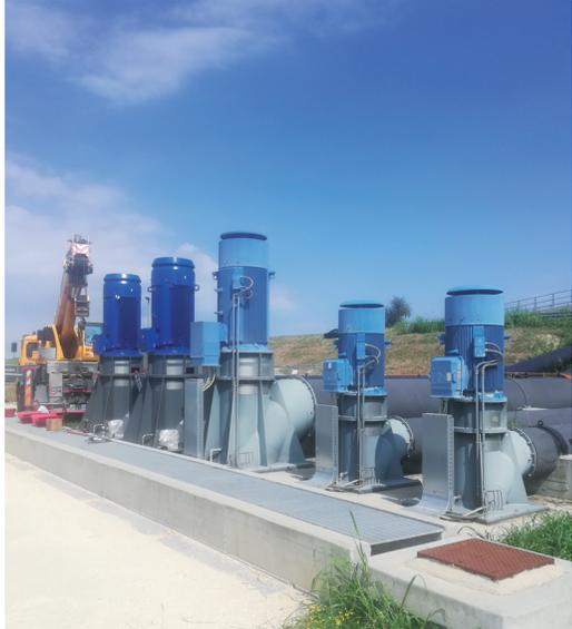
**Fig. 16** - Le due nuove elettropompe installate a sinistra vanno ad aggiungersi alle tre installate precedentemente
