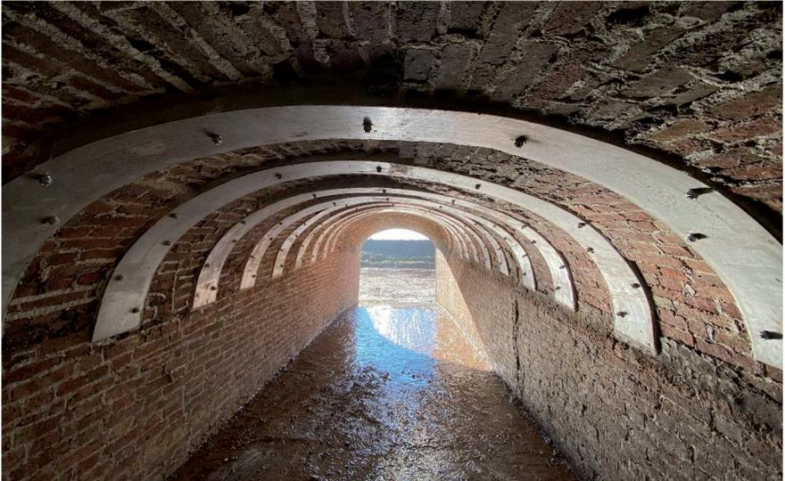
**Fig. 26** - Canna 2 centrale: messa in sicurezza e ripristino della volta
