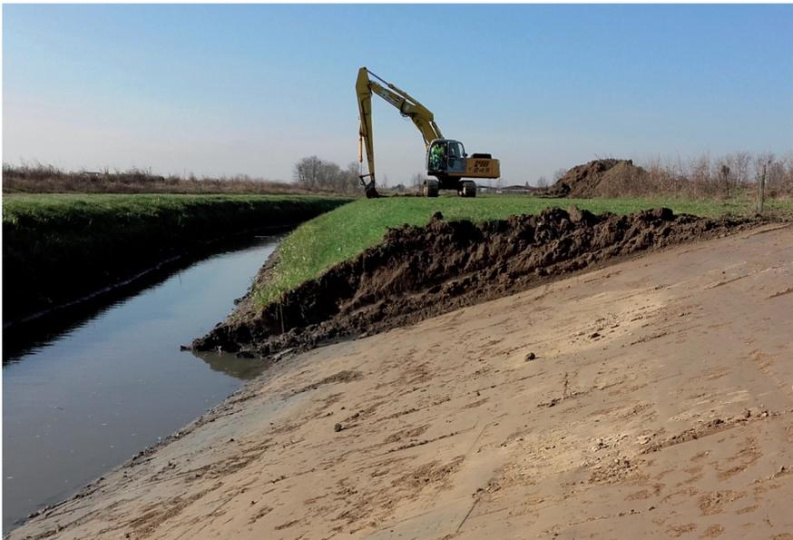
**Fig. 35** - Allargamento della sezione del canale Altipiano con pendenza delle sponde molto ridotta
