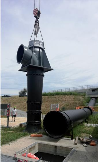
**Fig. 15** - Installazione di una delle due nuove elettropompe
